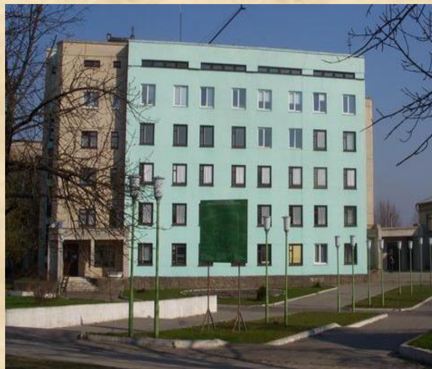
Здание больницы, 2010 г.
