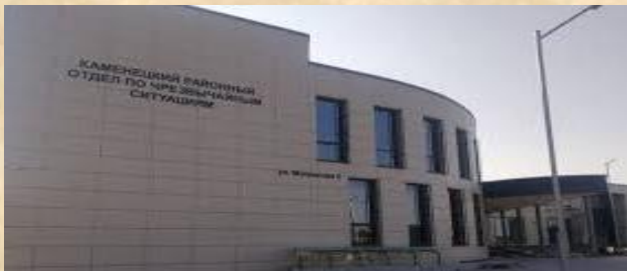
Новое здание пожарного пункта, 2020г.
