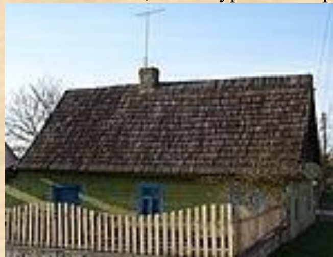
Крыша этого дома, покрыта гонтовой доской, 1960г.
