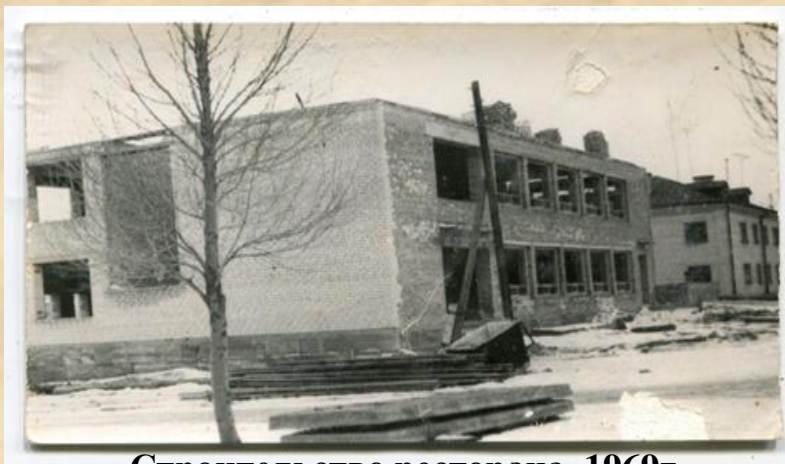
Строительство ресторана, 1969г.
