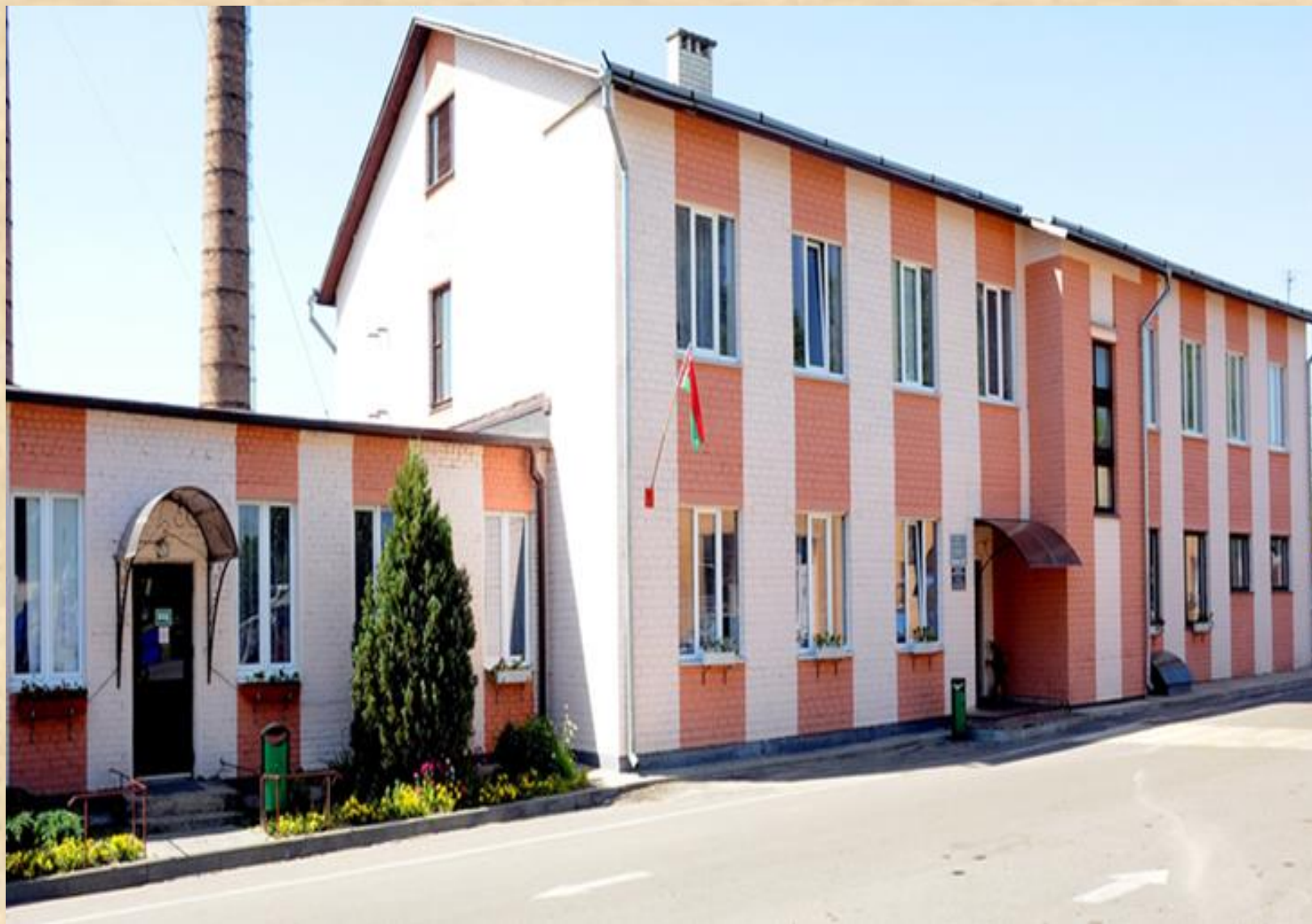
Здание КУМПП ЖКХ «Каменецкое ЖКХ», 2016г.
