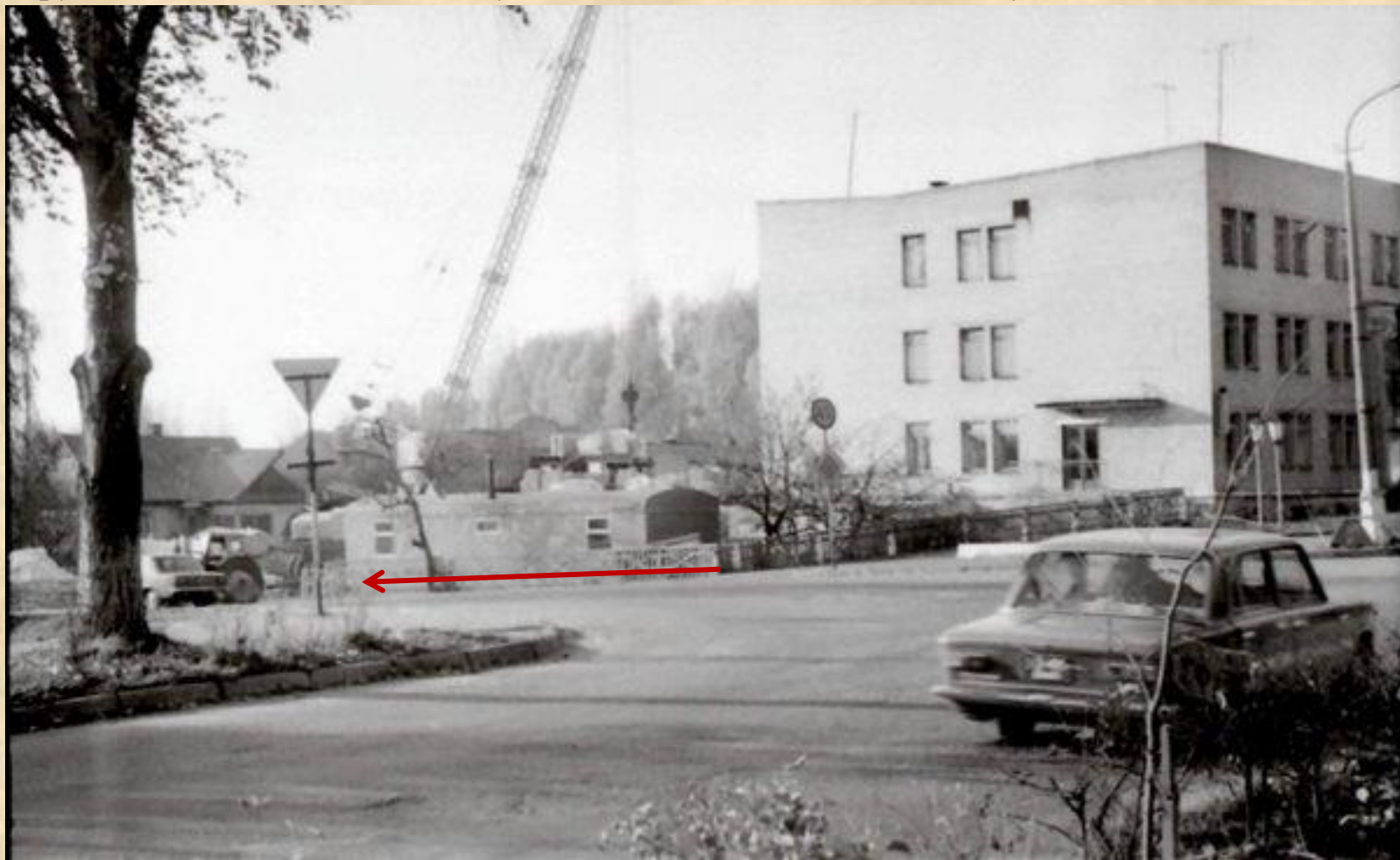
Перекрёсток улиц Брестской и Леваневского (ул. Пасека), 1987 г.
