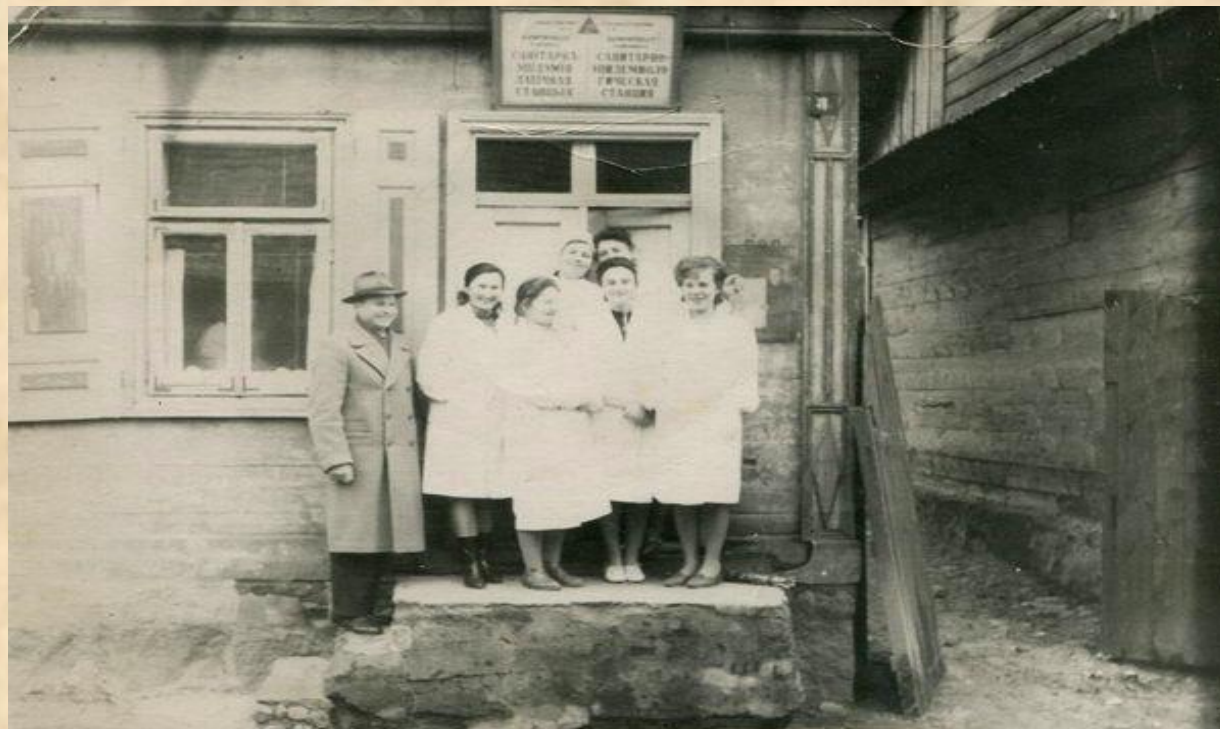
Здание санстанции, 50-е гг. XX в.
