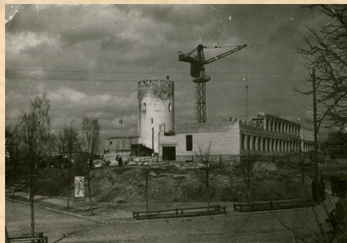
Возведение стен школы, 1962 г.
