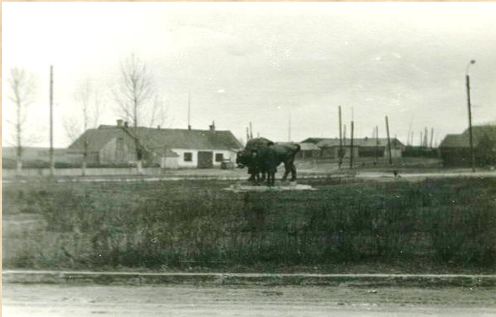
Общий вид на перекрёсток улиц Шоссейной (8-го Марта), Брестской и Маяковского, 60-е годы XX века.
