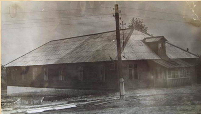
За зданием аптеки в 80-е гг. XX в. находилось здание санстанции.
